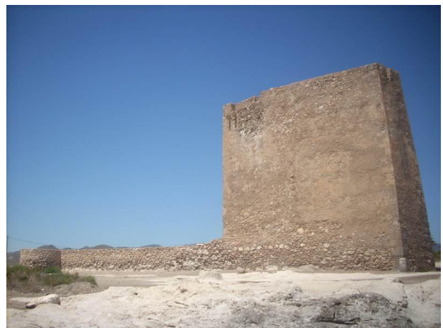
Ilustración 24. vista general. Sector Sur.
