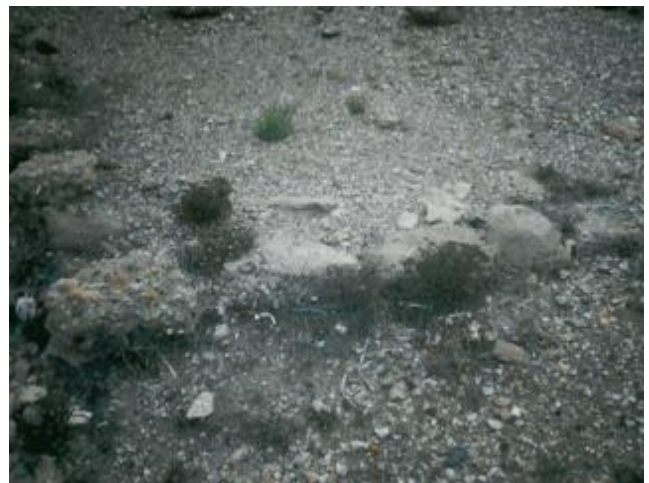
Ilustración 32. Detalle de estructura muraria.
