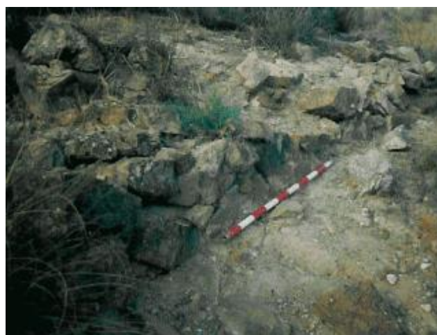
Ilustración 28. Detalle de estructura muraria.
