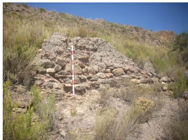
Ilustración 65. Detalle de tramo de muro de tapial. Sector occidental.
