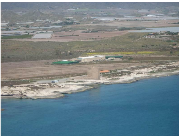
Ilustración 23. Vista general de la Torre en relación con el entorno en el que se ubica.
